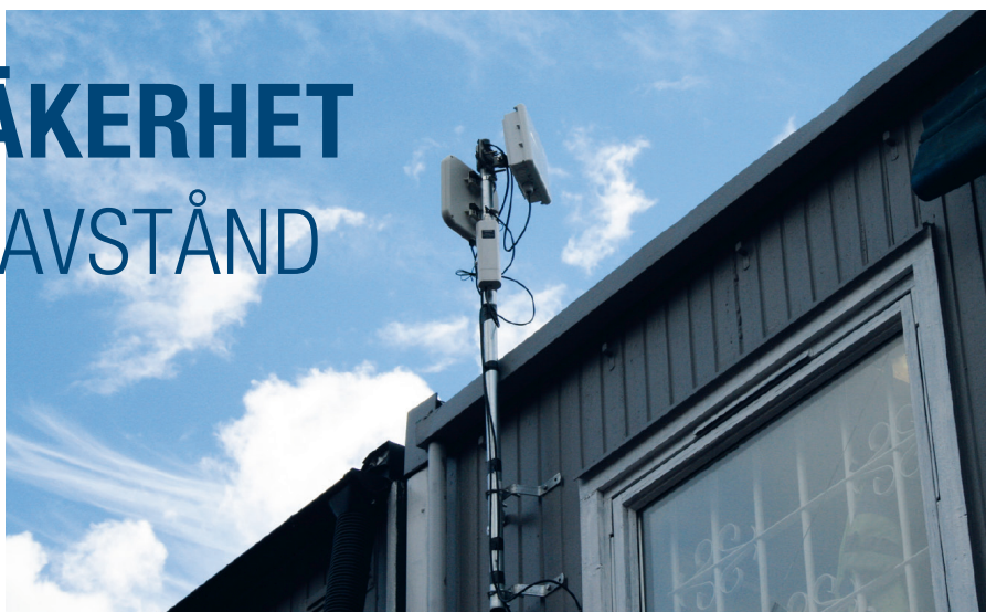
All information vidarebefordras med hjälp av trådlös kommunikation via antenner på arbetsbodarna.
